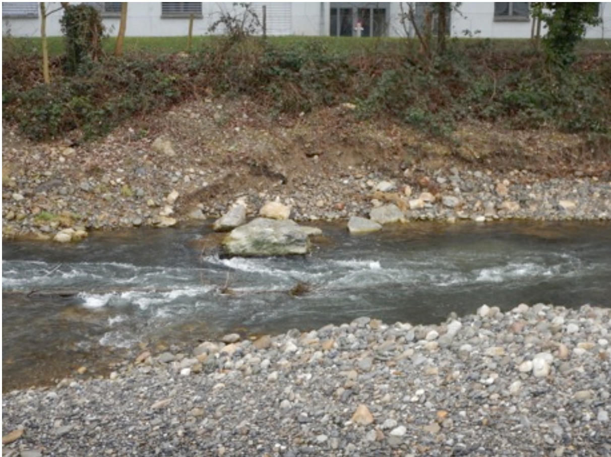
Abb. 13 Revitalisierung Restwasserkanal Bünz, Wildegg
