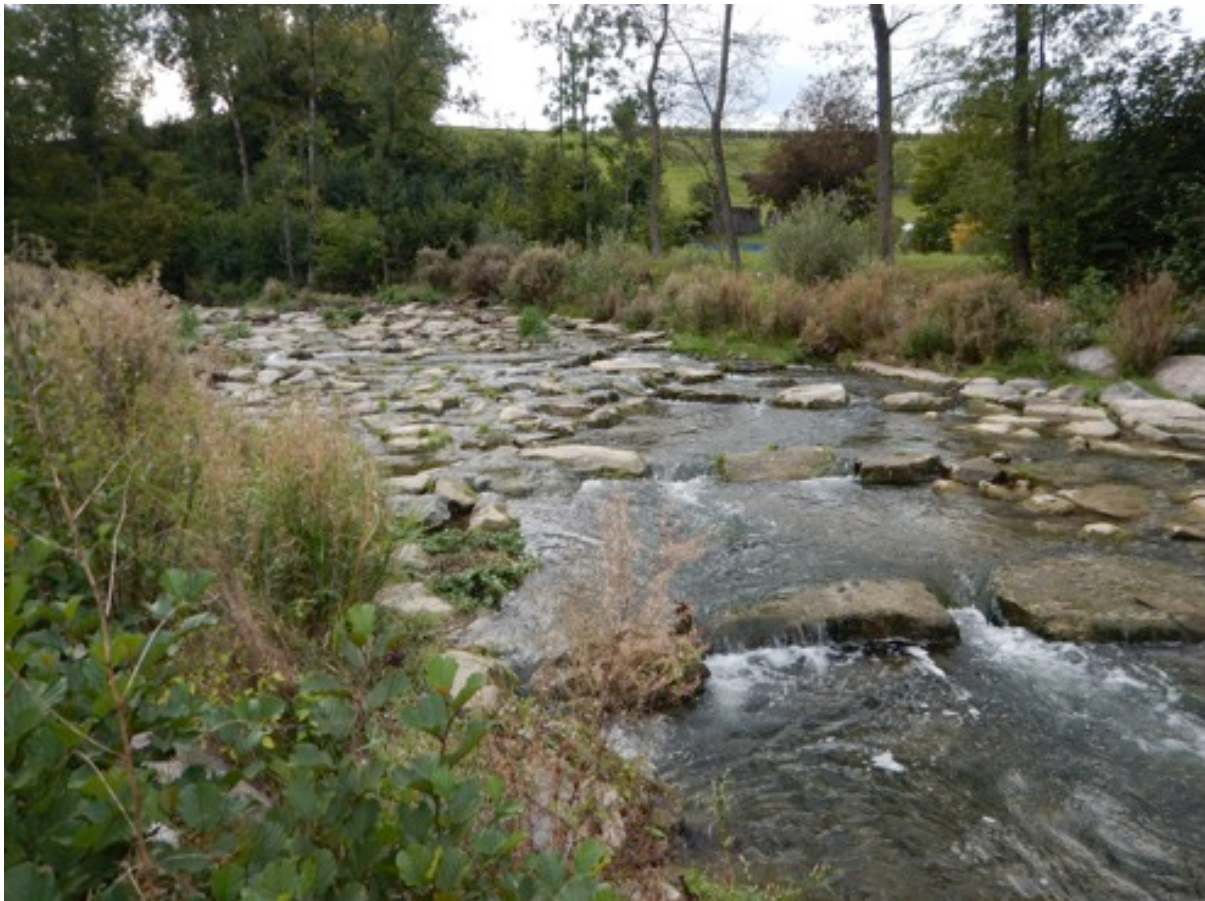
Abb. 5 Surb, Rampe bei Kläranlage
